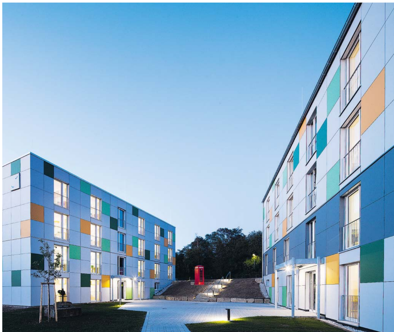
Trier setzt auf vorgefertigte, stapelbare Apartments.
